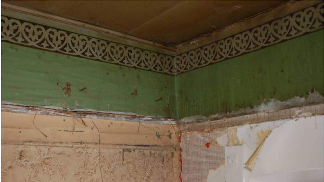
Figur 51: Stuehus, mellemstue. Påklæbet tapetbord som loftsfrise. Herunder grøn oliemaling og tapeter fra 1900-årene.
