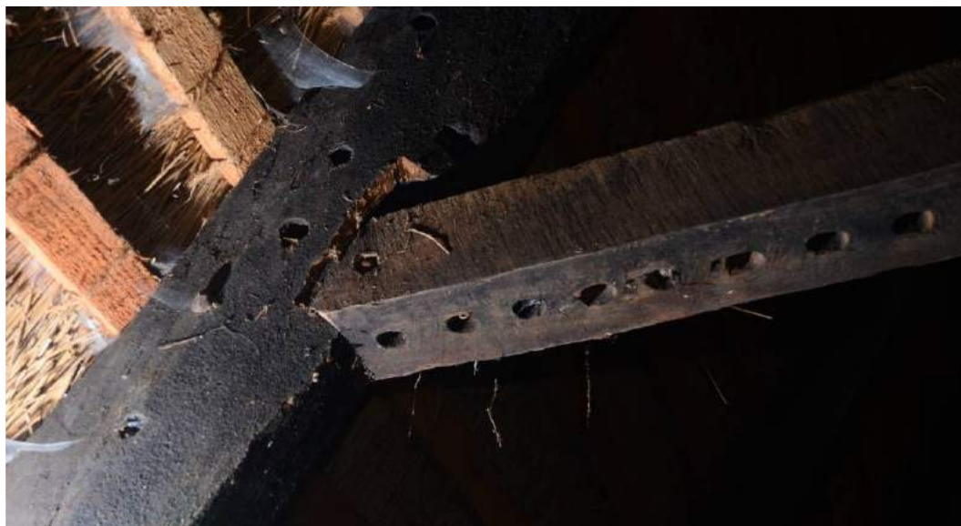
Figur 67: Hanebånd med tætsiddende skeborede stejlehuller. Tømmerdelen har formentlig indgået i tremmeværket til et fadebur. Foto 2018.
