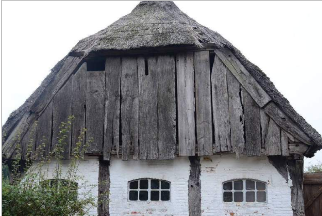
Figur 82: Vestlængens sydgavl. Gavlbeklædningen består af egebulplanker og genanvendte loftsplanker i fyr. Midt under valmen ses taphullet fra den midterste knægtkonsol under hanebåndet.
