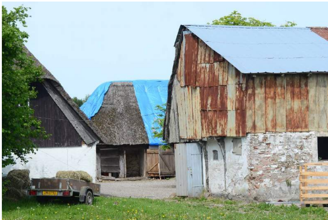
Figur 93: Østlængens sydgavl set fra sydøst. Den asymmetriske gavlprofil skyldes den nyere parallel-tilbygning med trempel på østfacaden. Den nærmeste stolpe med gavlnægt er bullhusets sydøstlige hjørnestolpe. Bag gavlens pandeplader står endnu den intakte gavlspærkonstruktion. Til venstre ses den nordlige halvdel af stuehusets østgavl.
