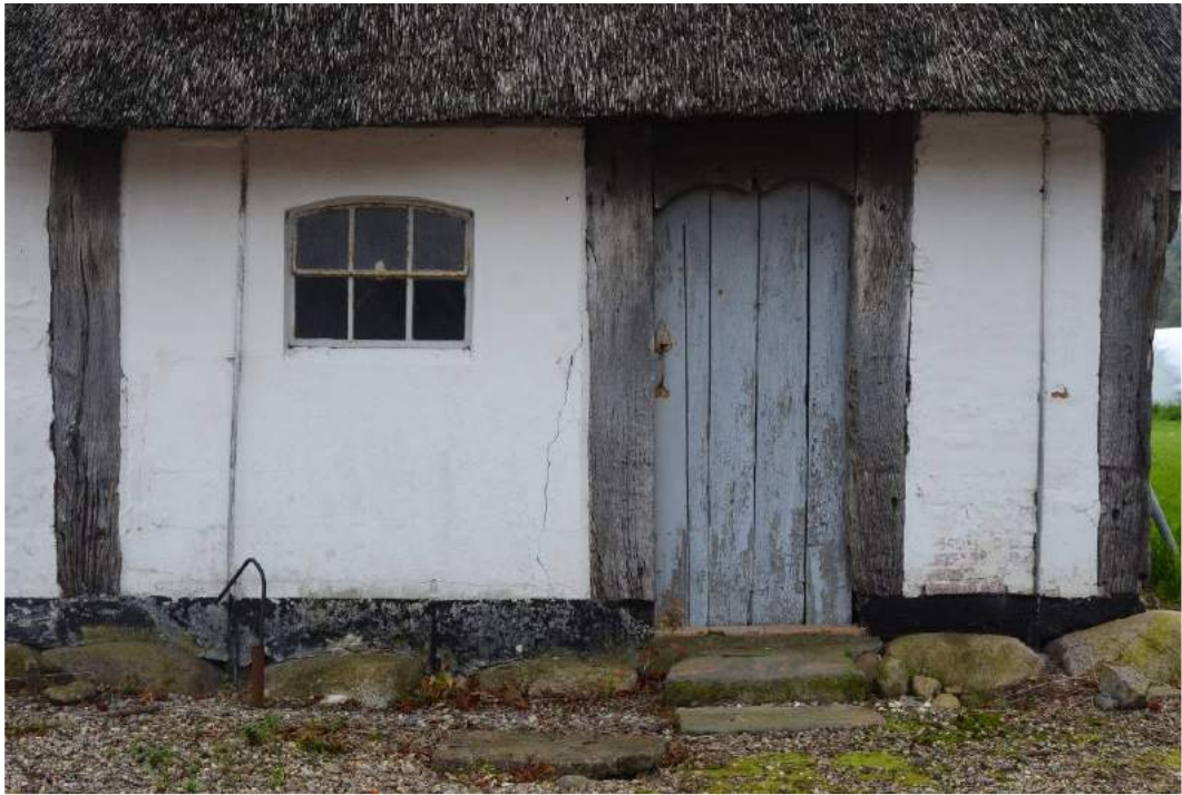
Figur 92: Østlængens vestfacade, sydlige del. Oprindelig dør med dørhammer i æselrygform.
