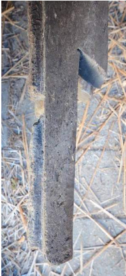
Figur 70: Gavlkipplankens nederste ende med skæl og skarp fjer. I kanten til venstre ses noten til gavlbulfjælene. Til højre, principskitse for et stavhus' forædlede konstruktion ved fodtømmeret.
