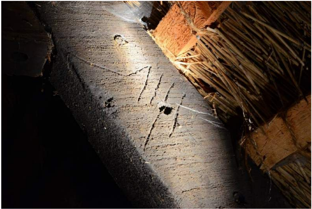
Figur 53: Romertal 'VIII' med fane på spær i sydsiden. På den sodsværtede tømmerflade ses savsporene fra en retfilet langsav.
