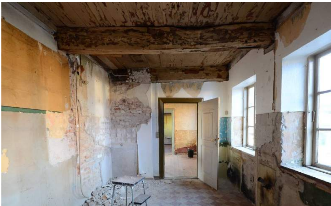
Figur 37: Stuehus, køkken, set mod vest. Dørblad med affrisninger og fyldinger med konkave hjørner i spejlene, 1700-årene. Til venstre for døren spor fra brændekomfur på det tidligere åbne ildsteds plads. Foto 2018.
