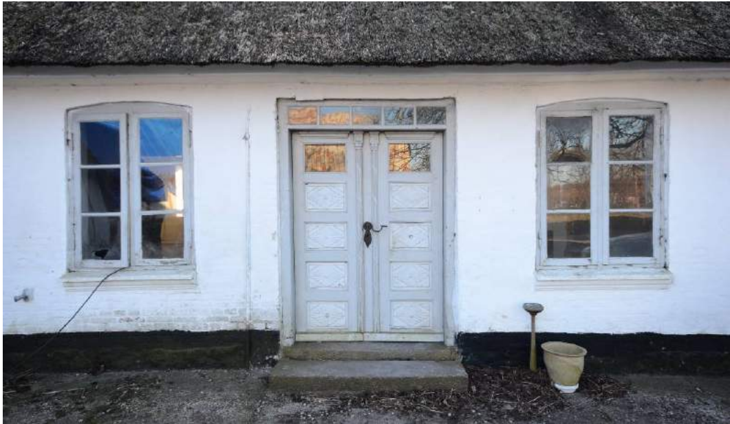
Figur 43: Stuehus, nordfacade. Indgang til baggangen.
