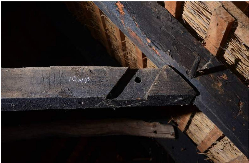
Figur 54: Spær nr. X set fra øst. Hanebåndet med nr. IIII og underbladet er genanvendt fra en tidligere afbinding. Foto 2018.
