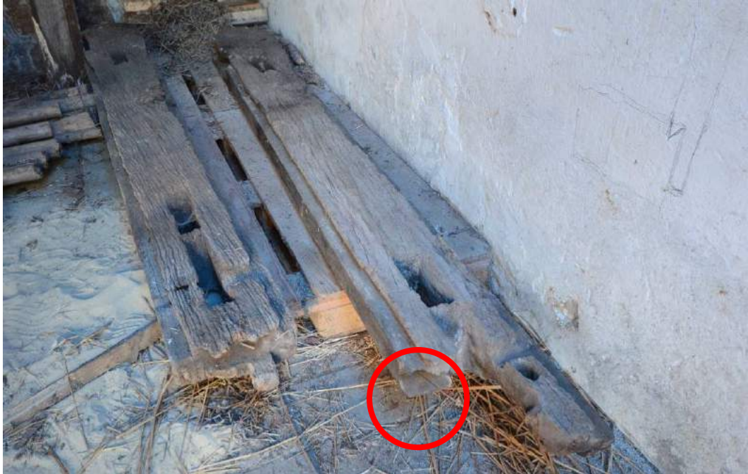
Figur 68: To gavlkipplanker. Bemærk den skarpe fjer nederst på planken til højre som er en samlingsdetalje fra stavhusenes tid.
