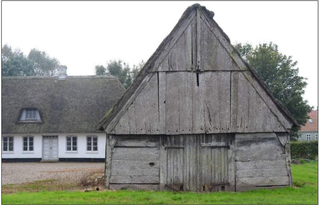
Figur 80: Vestlængens nordgavl. Hele gavlsituationen er flyttet omtrent to fag mod nord ved en bygningsændring i midten af 1800-årene. Til venstre ses stuehusets nordfacade med den vestlige indgang. I tagfladen en af de to senere kviste.
