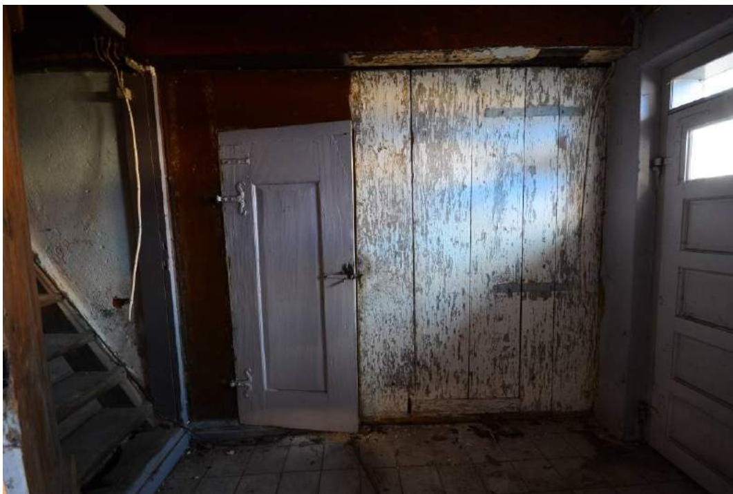
Figur 45: Plankeskillevæggen set fra baggangen. Enfyldingsdøren har bukkehornshængsler og klinkefald. Til venstre ses trappen til loftet.
