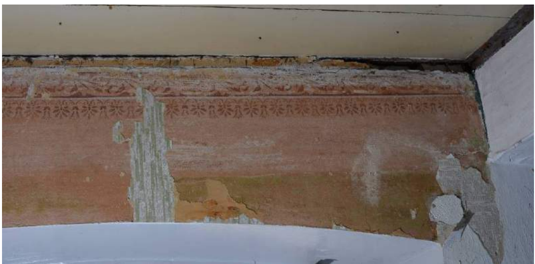
Figur 50: Stuehus, storstue. Skabelonfrise på nordfacadens indvendige pudsede flade.
