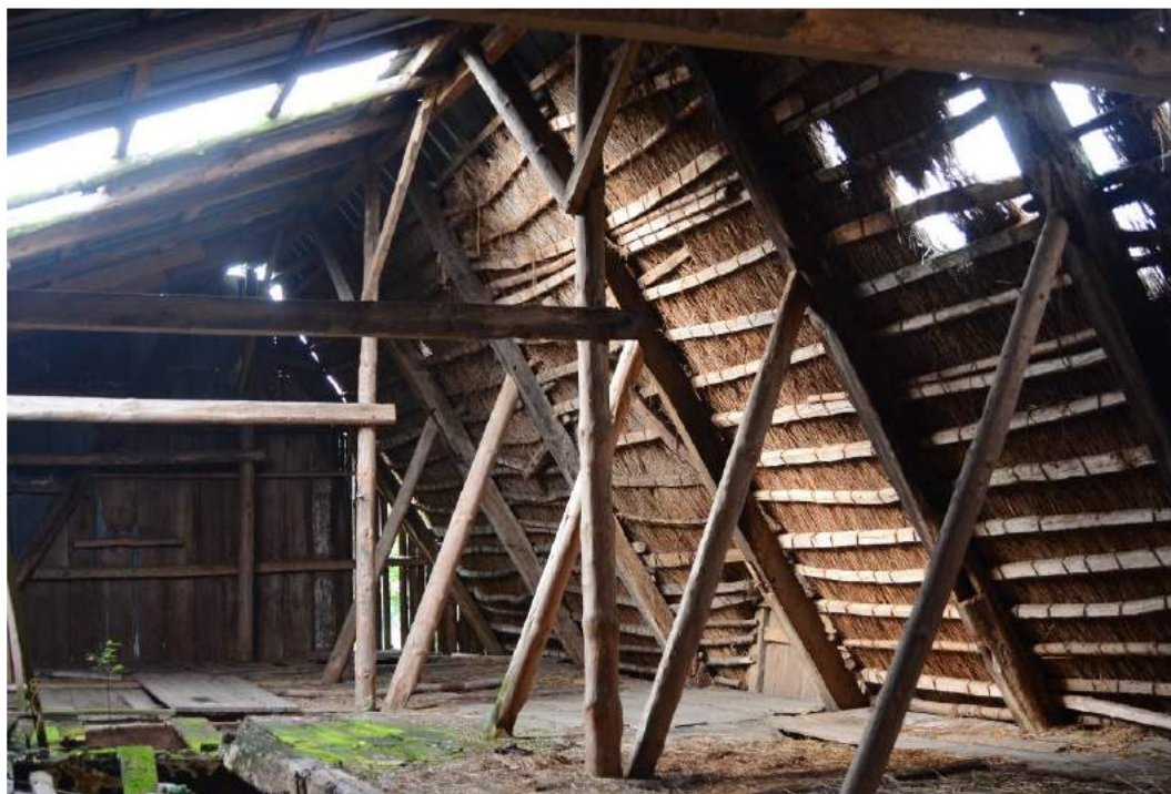
Figur 98: Østlængens oprindelige vestlige tagkonstruktion. Bagest i billedet ses den indvendige profil af den oprindelige gavlkonstruktion. Til venstre den østlige tagflade med lavere hældning, betinget af østlængens trempeludbygning.
