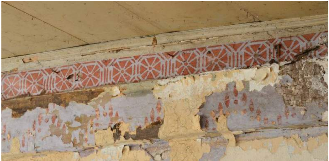
Figur 48: Stuehus, sydstue. Skabelonmalet loftsfrise med festoner.
