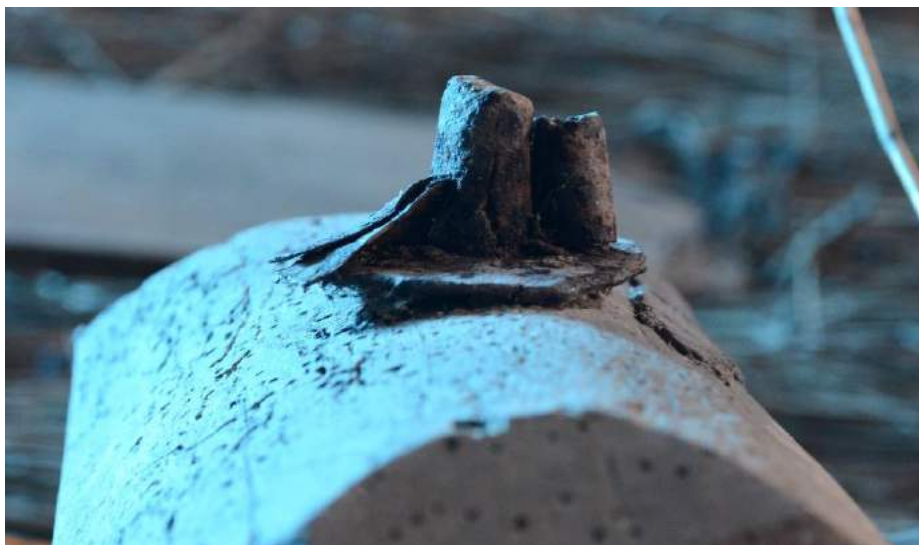
Figur 79: 'Låst' kilebolt, kilen er vejnet, i drager over den nyere garage. Foto 2018.
