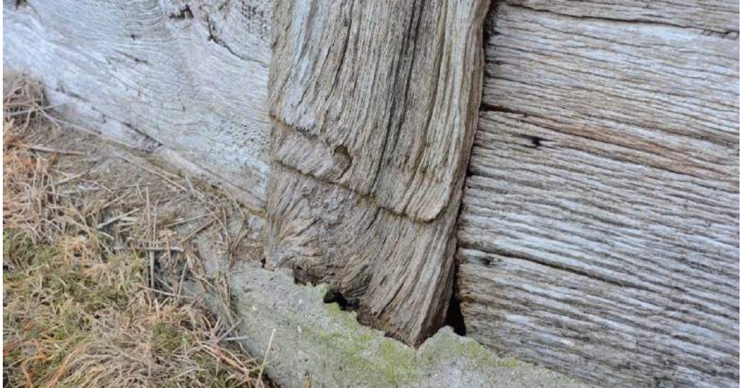
Figur 73: Hovedstolpe med tværprofileret vandnæse i vestlængens vestfacade. Stolpeskællet er delvist dækket af en nyere betonbræmme i terræn, eller bortrådneth.
