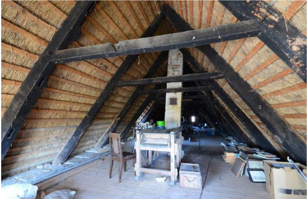
Figur 52: Stuehusets sodsværtede tagværk, set mod øst. Det forreste hanebånd er et genanvendt tagspær. Foto 2018.
