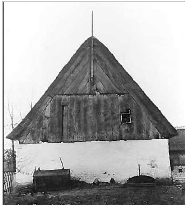
Figur 69: Stuehusgavl fra Vonsbæk By. Øverst på gavlen ses snedstillede planker sat i not i gavlkipplanken. Foto fra Nationalmuseets arkiv, 1890.
