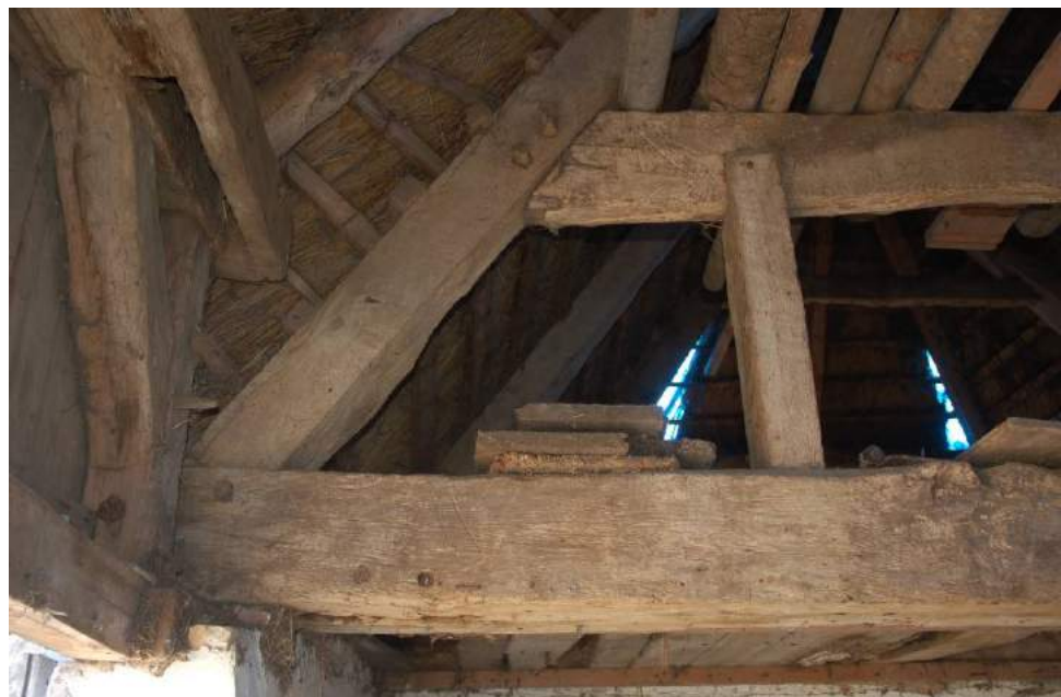
Figur 75: Vestlængen. Spær nr. 6 med skunkbjælke og skunkstolpe ved tærskeloen. Til tvøverst, den genanvendte porthammer fra tidligere gadeport i vestfacaden.
