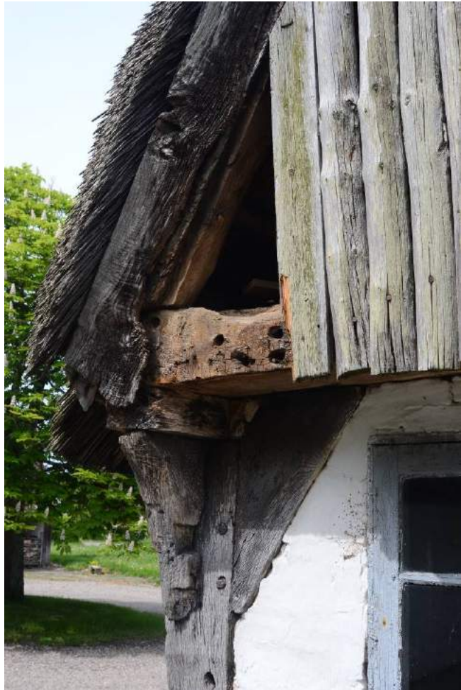
Figur 94: Vestlige hjørne på østlængens sydgavl. Bemærk den originale gavlbjælkes udkræning og svære dimension, samt den facettilsnittede gavlnægt. Foto 2018.
