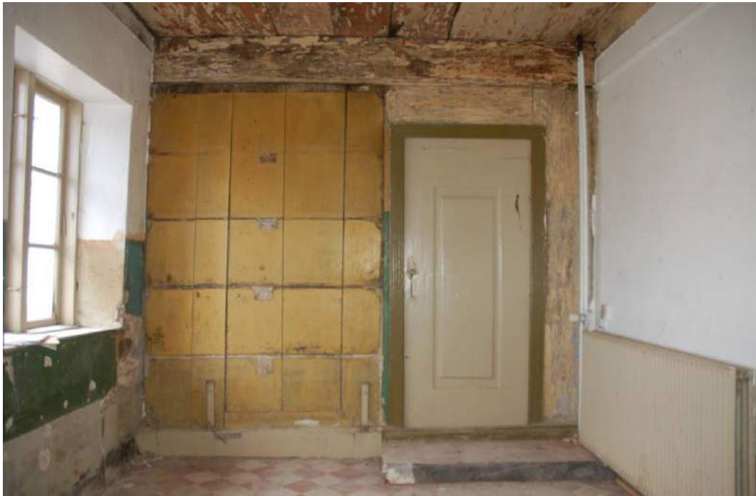
Figur 44: Stuehus, køkken. Enfyldingsdør i plankeskillevæg. Dørens rammetræ er reduceret. Ved skillevæggen og vinduesvæggen har der været faste bænke i forbindelse med et langbord.
