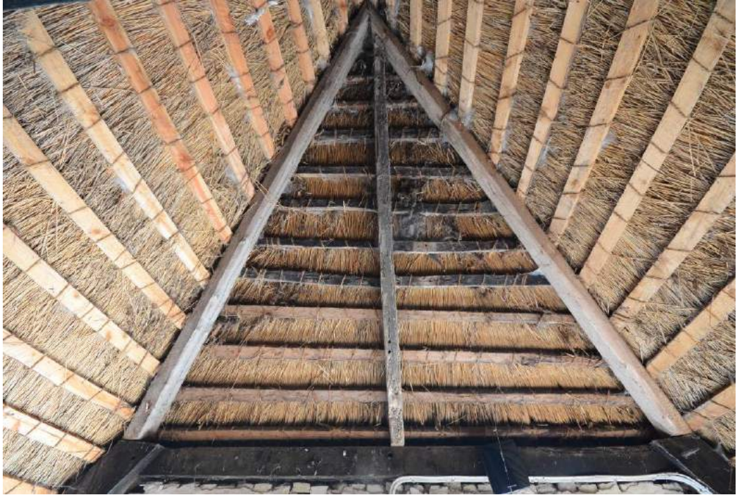
Figur 60: Stuehusets vestvalm. Det lodrette valmspær er en genanvendt husbrand. Hullerne fra dobbeltforaglingen kan ses forned og kan anes foroven. Bemærk de sodsværtede, genanvendte lægter øverst. De to gratsspær er ikke sodsværtede. På to af lægterne kan man se spor af de tidligere vederlag på spærret. Her ses lægtenaglehuller og ingen sodsværtning.
