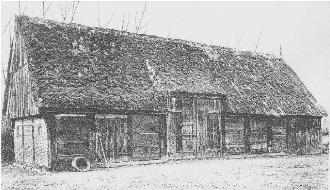
Figur 84: Ørby 20, vestlængens østfacade. Midt i facaden ses den forhøjede port af hensyn til et mobilt tærskværk. Dens porthammer stammer fra den tidligere gadeport fra længens nordlige ende. Til venstre i billedet ses sydgavlen før den blev afvalmet. I gavlspidsen anes gavlkipplanken. Foto: H. Zangenberg, 1923.
