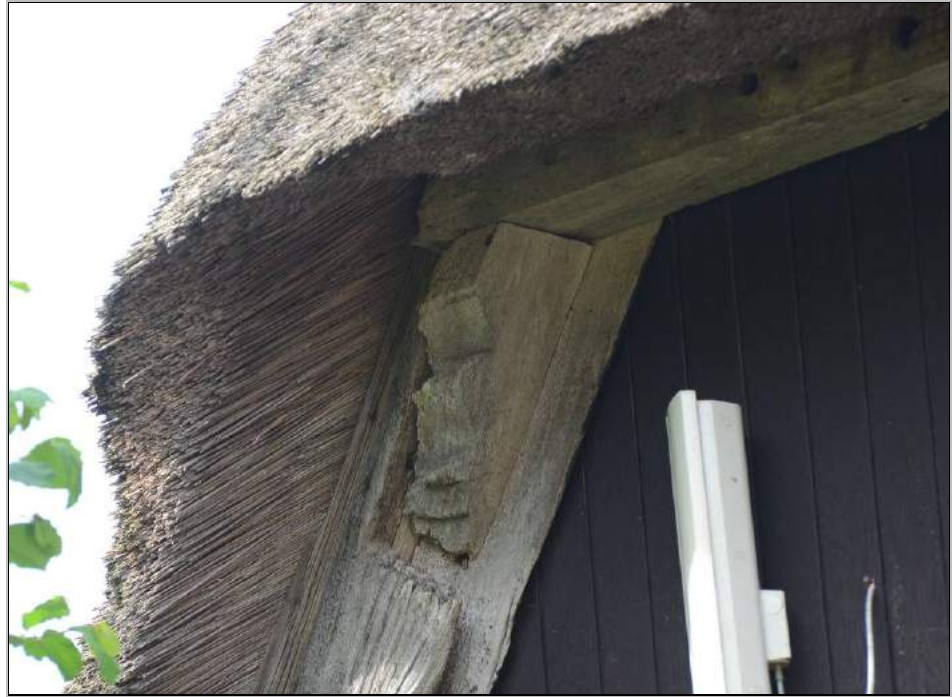
Figur 30: Stuehusets østgavl. Den sydlige skrå knægtkonsol under det udkragede hanebånd. Bemærk naglehuller på hanebåndets front samt vindskedens udskæring for knægtkonsollen. Foto 2018.
