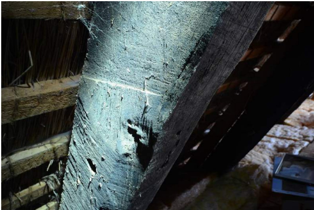
Figur 39: Stuehusets tagværk. Sodsværtede spær med spor fra langsav. Den trekantede form er et spor fra arbejdsprocessen, der viser at man skar ind fra begge ender. Trekanten fremkommer ved mødet mellem de to savsnit, som en kløvet flade.
