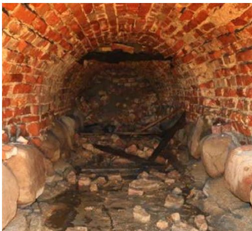
Velbevaret vandtunnelanlæg under Christiansborgs slotsplads fra 15-1600-tallet. Under tæt bebyggelse i byerne er der overraskelser som denne, andre gange findes komplekse kulturlag, der er rig på information om byens struktur og funktion i tid og rum. Foto: Københavns Museum
