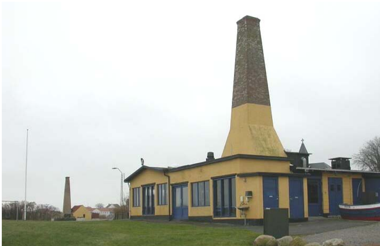
Røgeriet, Allinge Røgeri, nord for Petersens røgeri, som ses i baggrunden. Allinge røgeri er bygget senere og er større med to ildsteder. Det har derfor en stor bredde nederst og skorstenene er ofte delt hele vejen op. Dette røgeri er i funktion om sommeren, men meget ombygget og benyttes til turistformål.
