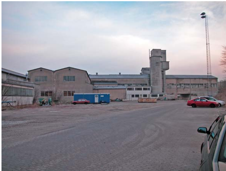
Figur 51. Siporexfabrikken, hvor produktionen foregik i flere etager, og hvor transporten af materialer og produkter fandt sted med skinnekørende kraner. 2004. Foto Morten Pedersen.
