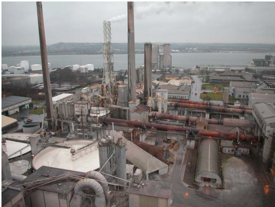
Figur 37. Aalborg Portland 2004. Vue over en del af roterovnsområdet. Forrest til venstre slemmebassiner, i midten varmegenvindingsanlæg. Foto Morten Pedersen.
