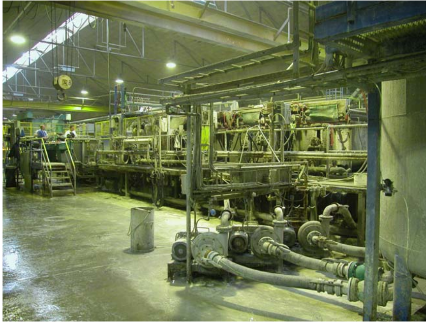
Figur 52. Anlæg til fremstilling af eternitplader i siporex-fabrikkens gamle kranlager. 2004. Fot o Morten Pedersen.
