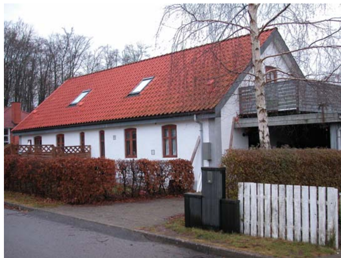
Figur 24. Tidligere dobbelthus i Pumpestræde til udlejning til arbejdere på Godthaab Hammerværk. 2004. Foto Morten Pedersen.
