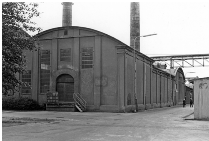
Figur 13. Kraftcentralen på Dansk Andels Cementfabrik ved Nørresundby – procesanlæg eller hal? Efter Industrialismens bygninger og boliger, lb.nr. 5255.
