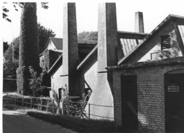
Figur 21. Vestre smedje på Godthaab Hammerværk, bygget 1915, ved industriregistreringen i 1977. Skorstenene til esserne er ældre.
