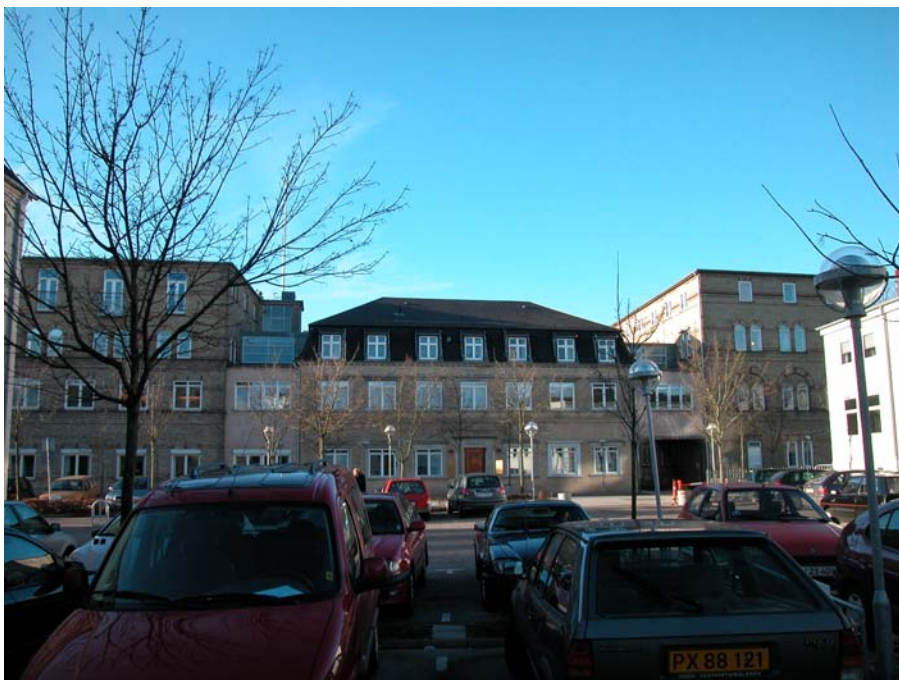
Figur 33. Administrationsbygningen ved C.W. Obels Tobaksfabrik set fra Badehusvej med indgangene til fabrikken på hver side. 2004. Foto Morten Pedersen.
