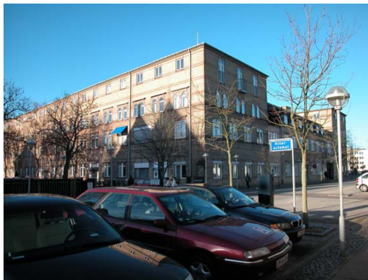
C.W. Obels Tobaksfabriks front mod Badehusvej i Aalborg. I dag rummer bygningerne bl.a. Aalborg Universitet. Foto Morten Pedersen.
