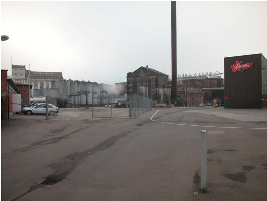
Figur 28. Det bagerste område af spritfabrikken med sprittanke, kedelhus og skorsten mm. Fotograferet gennem hegnet ud mod Limfjordskajen. 2004. Foto Morten Pedersen
