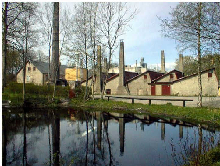
Figur 8. Godthaab Hammerværk med mølløsøen i forgrunden, vestre smedje i midten og administrations- og beboelsesbygningen til venstre. 2003. Foto Inger Bladt.
