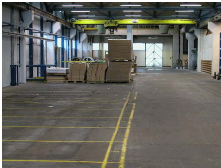
Figur 15. Fra Dansk Eternit Fabrik A/S. Parti fra shed-tagsbygningen med stor højde, skinnekørende loftsborne kraner og niveauinddelinger i baggrunden (bunden af to siloer ses stikke ned fra oven). – Fladebygning, hal eller etagebygning? Foto Morten Pedersen
