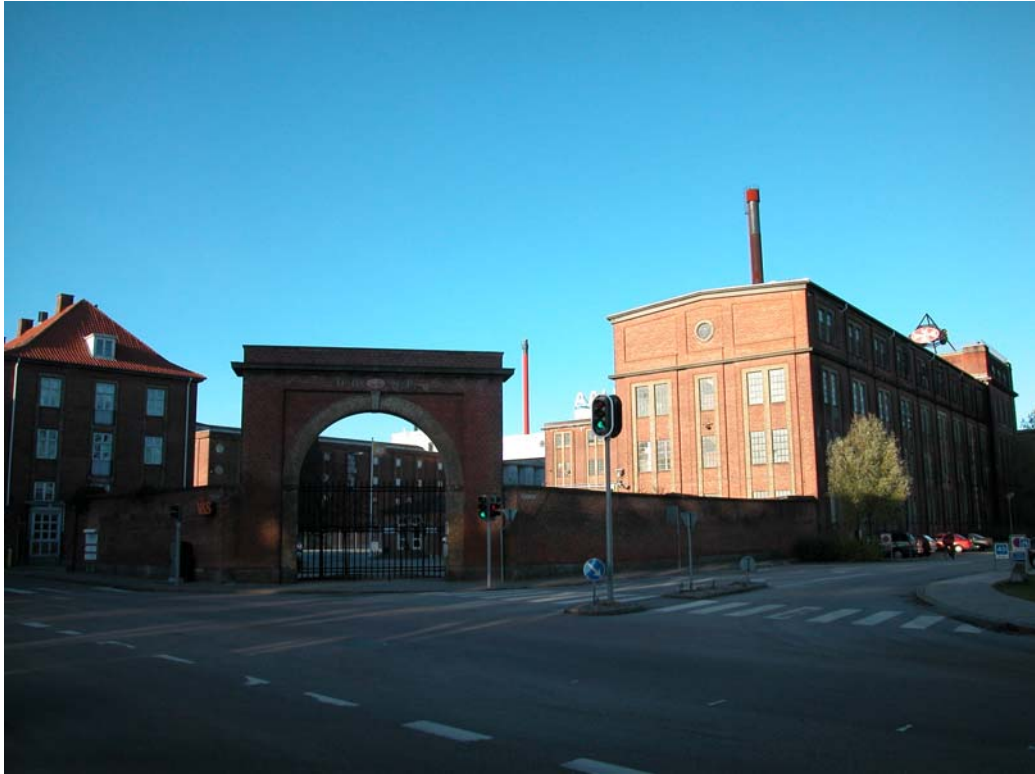
Figur 26. Indgangen til spritfabrikkens gårdsplads fra Strandvejen. Administrationsbygning til venstre og aftapningshal til højre. 2004. Foto Morten Pedersen.
