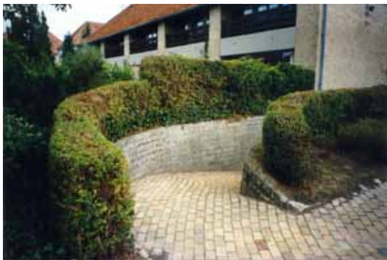
Foto af nuværende ramper til affaldsrum. Ramperne må ikke længere anvendes ved afhentning af dagrenovation.
