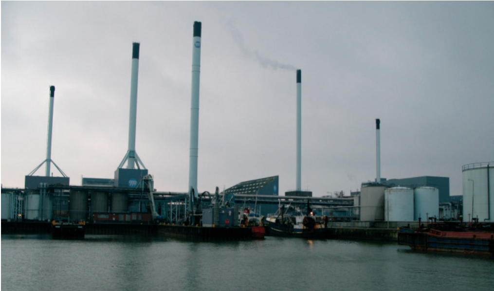
999-komplekset dækker et stort areal på Esbjerg Havn
