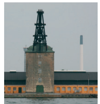
Mastekranen på Holmen (Foto fra KIP-registrering 2006).
