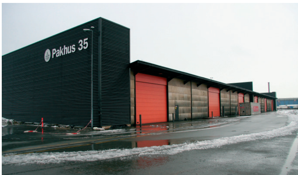
Pakhuse fra 1990'erne på Århus Havn tegnet af arkitektfirmaet C.F. Møller (Foto fra KIP-registrering).
