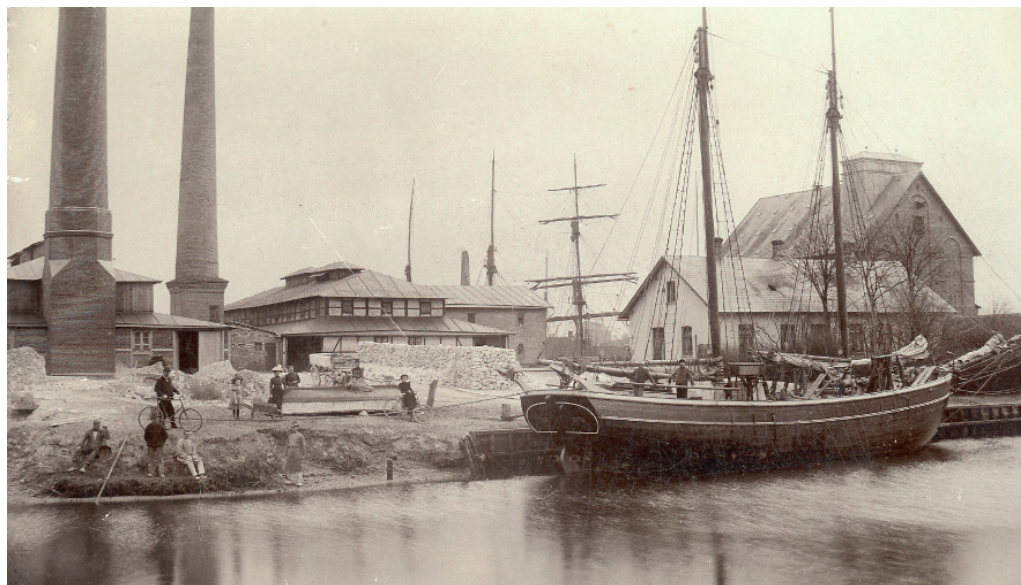
Odense Kalkværk med to store ringovnsanlæg og tilhørende skorstene ca. 1900. Kalk blev sejlet ind fra Fakse, og brændt i ovnene fra hhv. anlæggelsen i 1875 og udvidelsen i 1898. Bemærk kalkstenene opmagasineret i forgrunden samt beboelseshuset th. bag skibet. (Odense Bys Museer)
