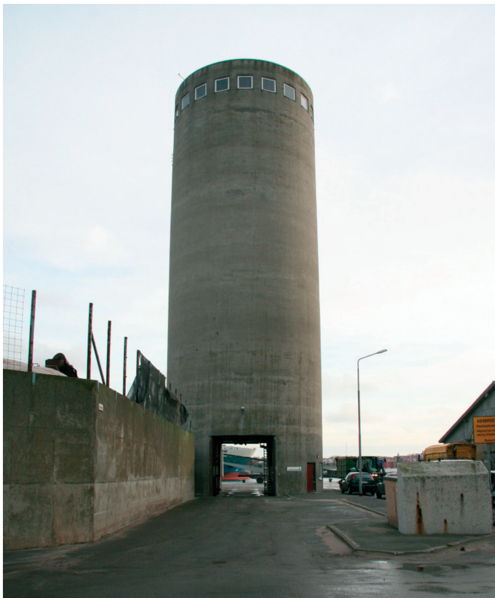
Cementsilo på Rønne Havn (Foto fra IP-registrering 2006).
