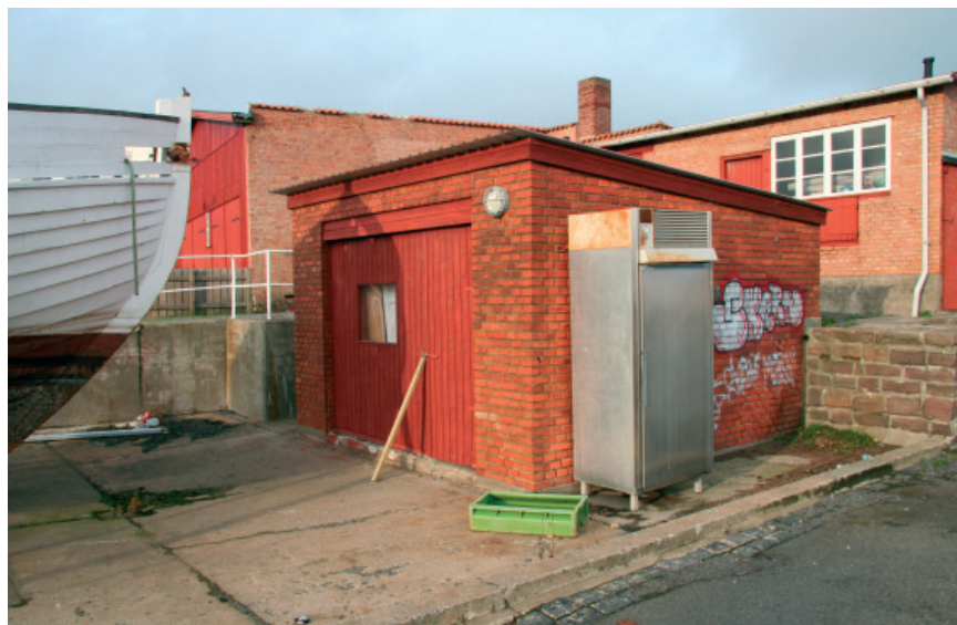
To generationer af spillhuse i Nekso. På det ældste spillhus, formentlig fra 1930'erne, ses de typiske låger til gangspillet under vinduet (Foto fra KIP-registrering 2006).
