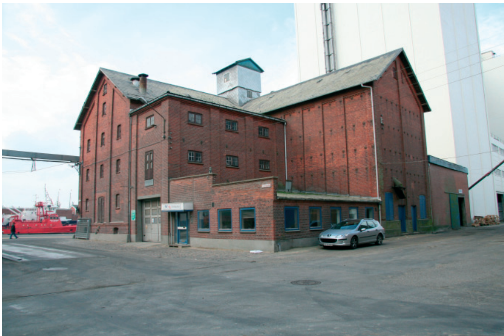
Oxenbjerg Dampmølle med silo th. på havnen i Svendborg (Foto fra KIP-registrering).
