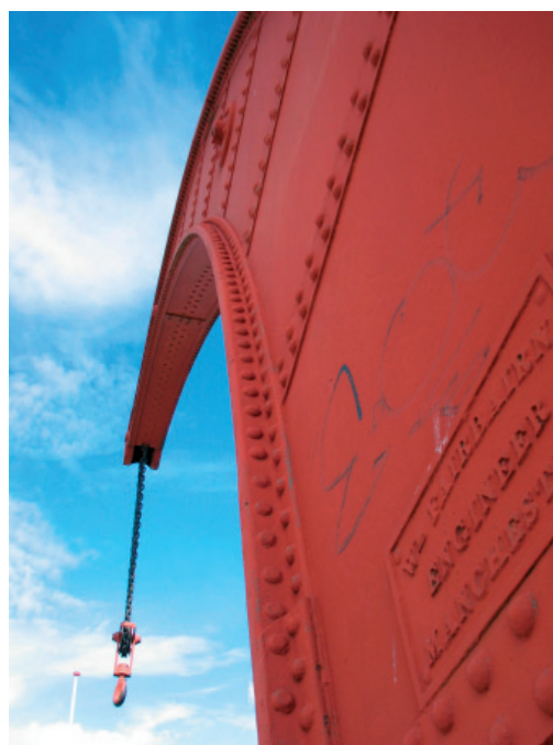
To eksempler på bevarede kraner, der begge burde være bygningsfredede. Tv. en lille svingkrane placeret på Nordre Toldbod i København, støbt i Frederiksværk i 1848. Th. en nittet pladekonstruktion fremstillet hos William Fairbairn i England, formentlig o. 1870 (Fotos fra KIP-registrering 2006).
