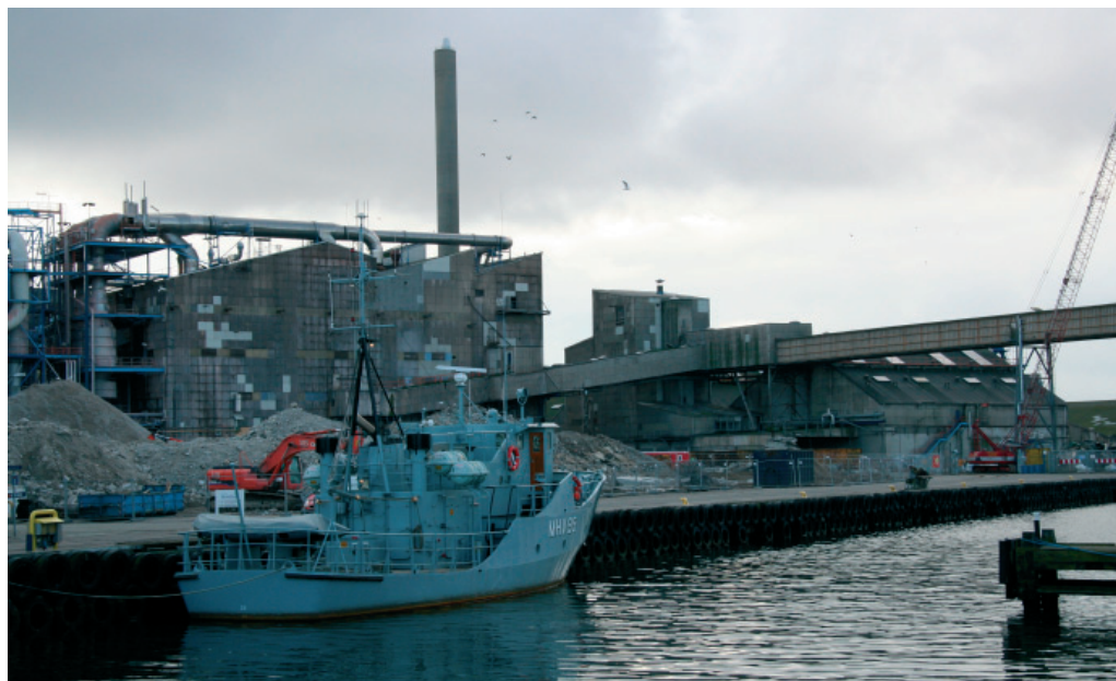
Chemiras anlæg ved Fredericias indre havn under nedrivning sommeren 2006 (HH fot.)
