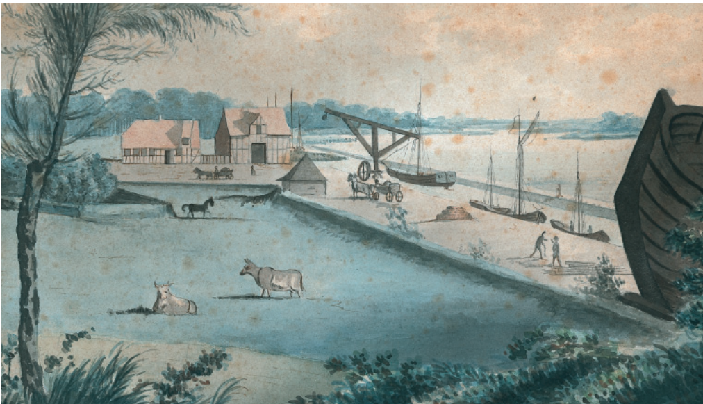
Klassisk drejelig vippekrane i tømmer ved Skibhusene udenfor Odense ca. 1820. Bemærk skibene langs bolværket og deres ringe størrelse. (Odense Bys Museer fot., udsnit).
