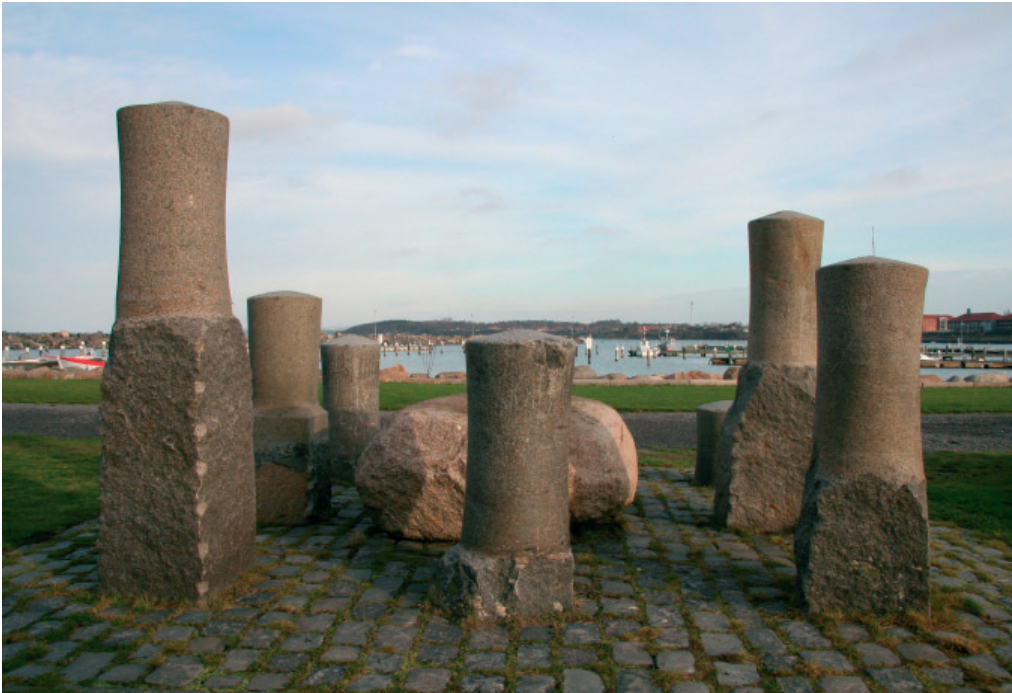
På Rønne Havn findes en lokal samling af granitpullerter frigjort fra deres rette element og udformet som en skulptur. Opstillingen giver en vis mulighed for at se pullerternes base. De viste pullerter er typiske for danske havne i den klassiske industrialiseringsperiode (Foto fra KIP-registrering 2006).
