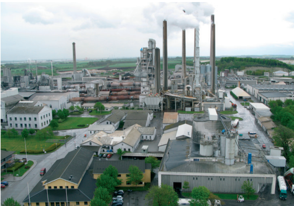
Aalborg Portland cementfabrikken i Rørdal set fra fabrikens havnesilo (Foto fra KIP-registrering).
