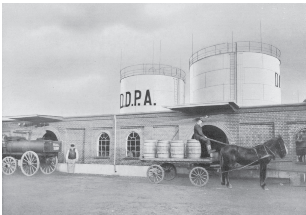
DDPA's anlæg i Køge omkring 1920. På billedet ses tankanlæg, tilhørende tøndelager med perroner og både tøndetransport og tankvogn (Efter Schovelin).
